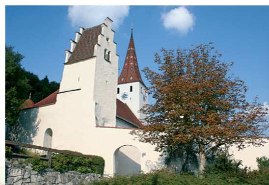
Die Kindinger Kirche gleicht mit ihren Türmen, Treppen- giebeln, schießscharten- ähnlichen Öffnungen und wuchtigen Mauern einer Befestigungsanlage.
